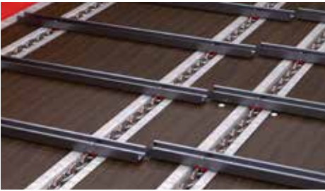
Podłoga z drewna, które nie ulegają procesom niszczenia przy kontakcie z obornikiem
